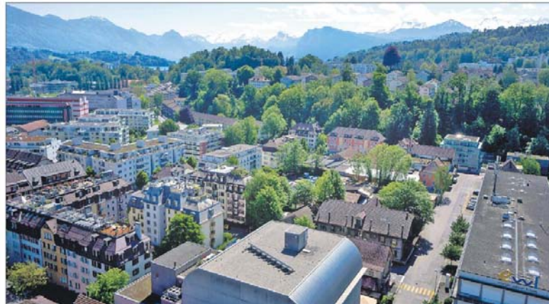
Das Gebiet rund um die Industriestrasse (rechts im Bild) von oben. Es könnte möglicherweise so überbaut werden wie die Feldbreite in Emmen (siehe unten). Luftvideos.ch
