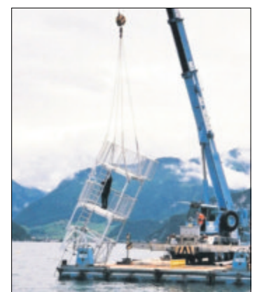
Der neue Sprungturm im Horwer Seebad.
