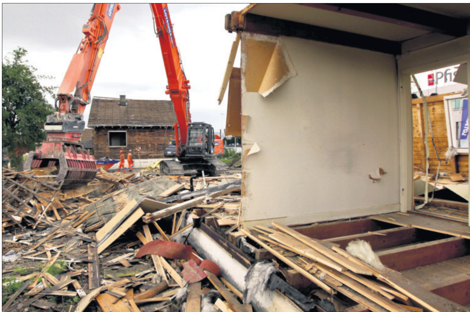
Die Abbrucharbeiten beim Schindlerdörfli in Emmen laufen auf Hochtouren. Bild Philipp Schmidli
