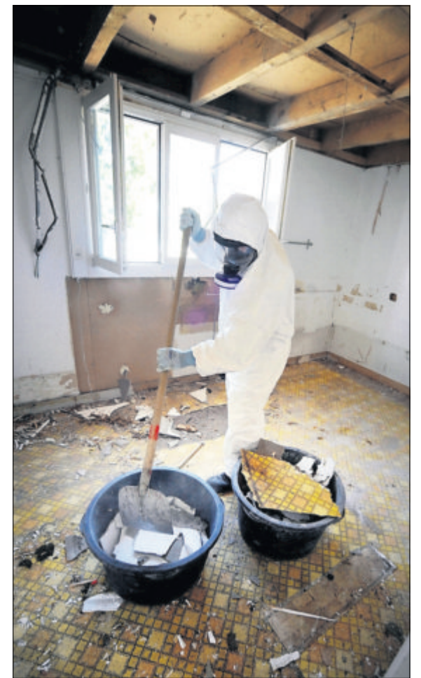
Akribisch werden die Häuser des Schindler-Dörfli zurückgebaut. Für den Abbau der asbesthaltigen Fassadenschindeln sind Schutzkleider (Bild rechts) nötig.
