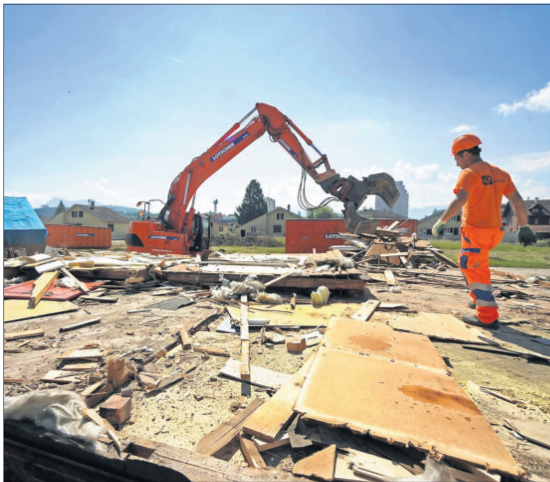
Akribisch werden die Häuser des Schindler-Dörfli zurückgebaut. Für den Abbau der asbesthaltigen Fassadenschindeln sind Schutzkleider (Bild rechts) nötig.
